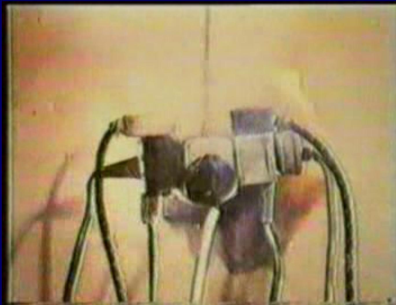
•我国普通居民楼居室的电源导线一般设计为6—10安培，总负荷不宜超过1000—1500瓦，当用电总功率超过2000瓦时就存在电线短路起火、电表烧毁的可能。
