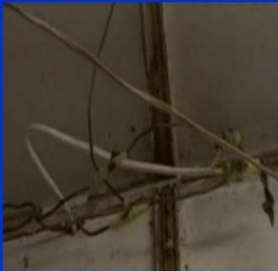
电线老化
